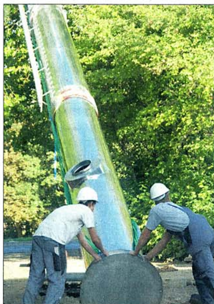
Der Kamin wiegt 1,5 Tonnen.
